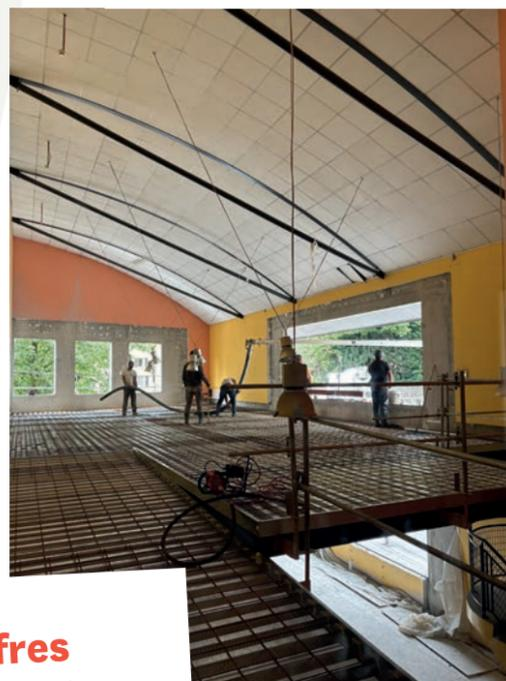
Associée aux poutres et à une structure en acier, une dalle béton a été créée.
