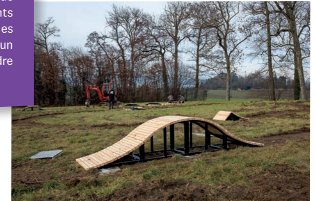
La pose des modules a été réalisée fin décembre.
