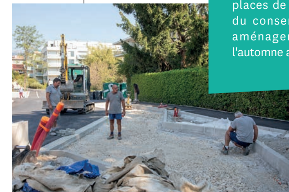
Les places de parking sont recouvertes de pavés engazonnés pour améliorer la pénétration des eaux pluviales et l'impact écologique du projet.
