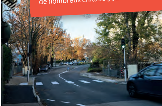
L'installation des feux, le marquage au sol et la reprise de la chaussée autour du carrefour ont été réalisés en novembre 2023.
