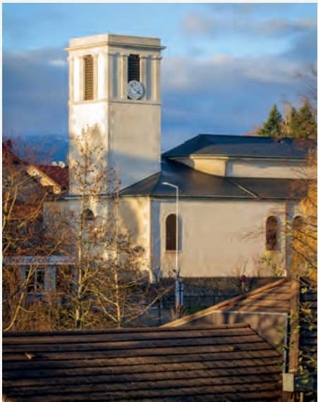
L'église a été restaurée dans le respect de son aspect original.
