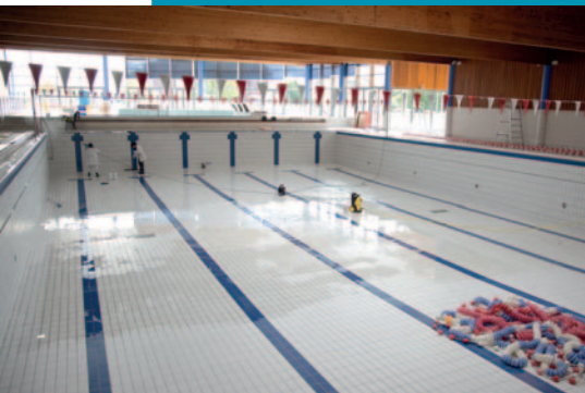
La vidange annuelle des bassins est une étape obligatoire qui permet de maîtriser la bonne qualité de l'eau.
