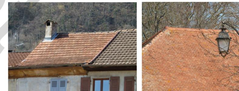
Exemples de formes de toitures et de couvertures anciennes en tuiles écailles plates
