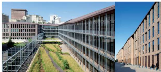
REF. CITÉ DES MÉTIERS D'HERMÈS Pantin / Complexe d'unités de création de mode Hermès France RDAI Architecture / Calq Architecture Cité des métiers de la création. Ateliers de modes, d'exposition, de création et des bureaux. surface bâtie : 75 000m 2
